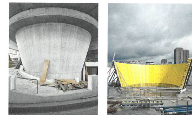
Die Verjüngung und Einfügung des Turmschafts in die Rampeanlage. Rechts: zugehörige Schalungsarbeiten.
