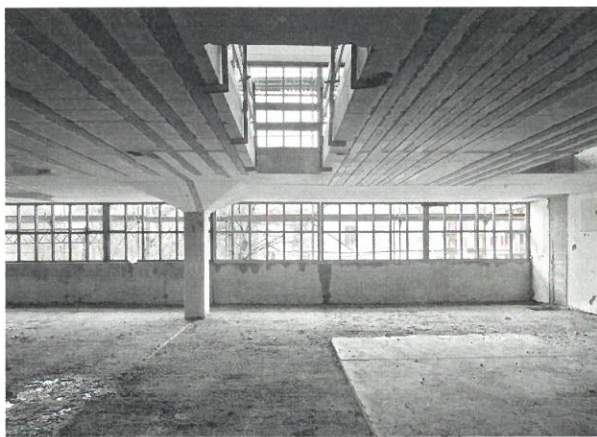
Stahlplatten zur Erhöhung des Biege widerstands im Feldbereich der Obergeschossdecken des Werkstattgebäudes.
