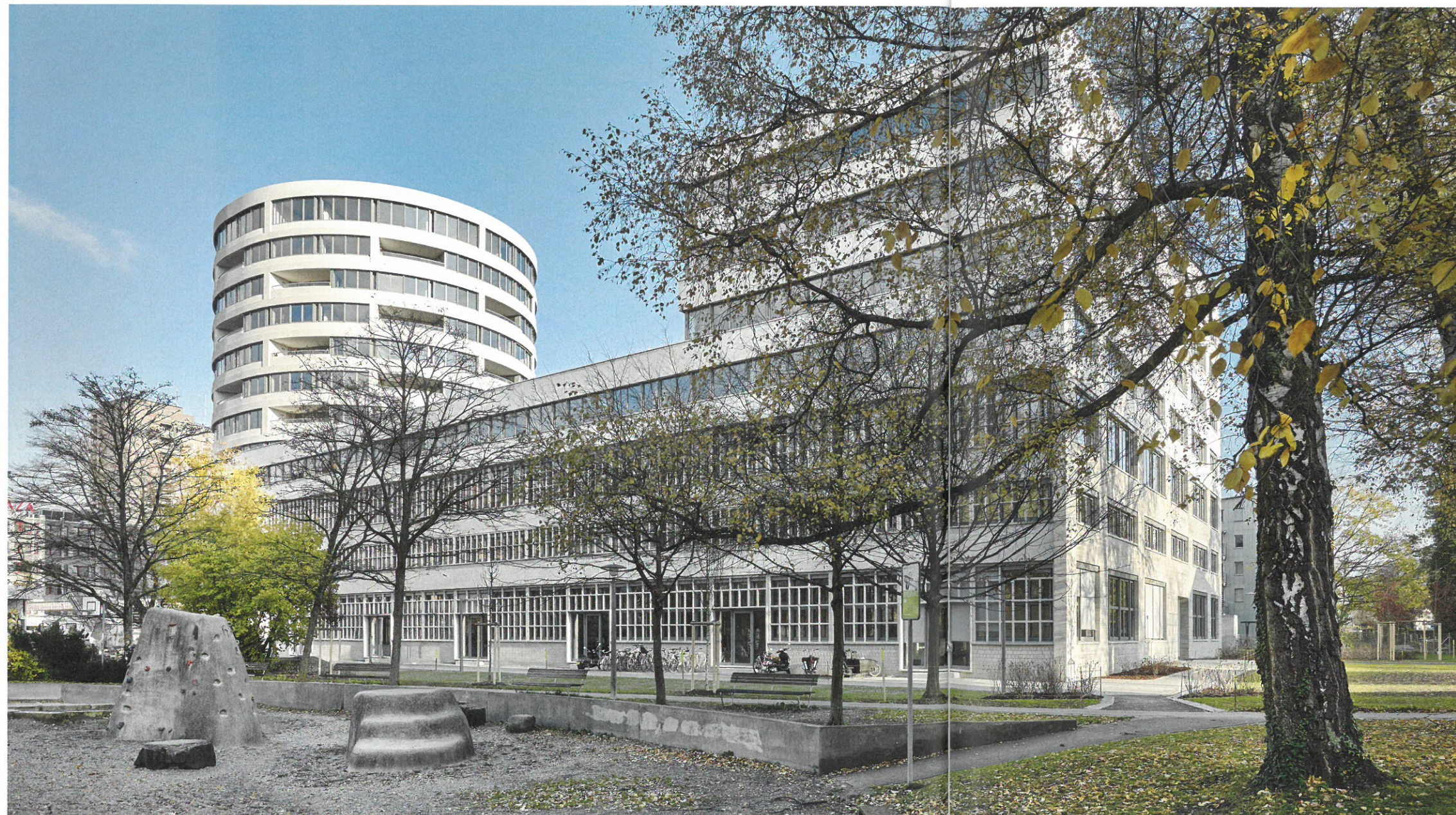
Blick vom Heiligfeld-Park: vorn das aufgestockte Werkstattgebäude, dahinter der neue Turm, der den Rampenbau überragt.
