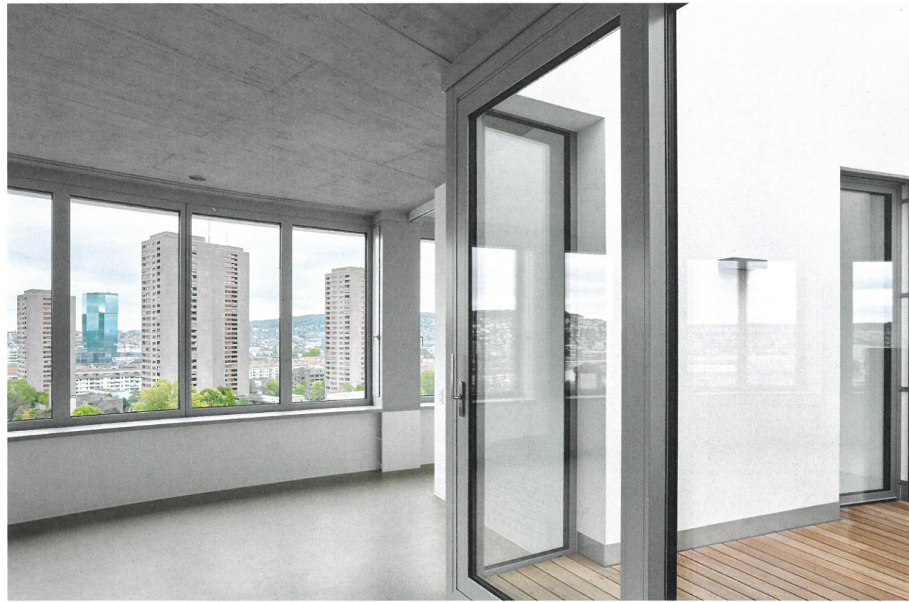
Wohnung im obersten Geschoss des neuen Turms: Im 11. OG gibt es keine Terrasse, sondern ein Atrium als privaten Aussenraum; dafür ist die gebogene Panoramafassade über die ganze Breite der Wohnung spürbar. Die Räume sind 2.9 m hoch. Der geschliffene Anhydrit-Unterlagsboden bildet den fertigen Bodenbelag und evoziert ebenso wie die roh belassene Betondecke den ehemals industriellen Charakter des Orts.
