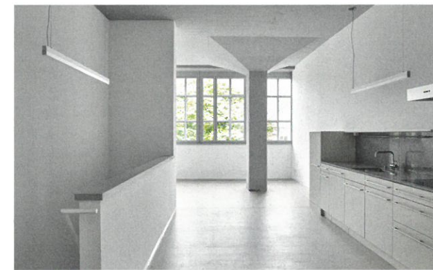
Maisonnettewohnung (oben) und Loftwohnung im Werkstattgebäude: Die Pilzstützen des Altbaus prägen die Identität der Räume. Die alte Fassade wurde samt Betongitter erhalten, die bestehende Verglasung durch neue Fenster ersetzt.
