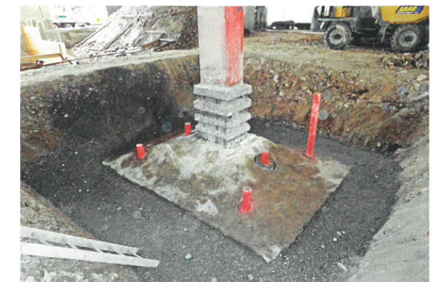
Einzelfundament mit Schubzähnen und durchdringenden, neuen Mikropfählen.
